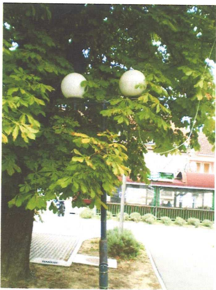
Slika 12. KUGLA KS-10 zasjenjena raslinjem
