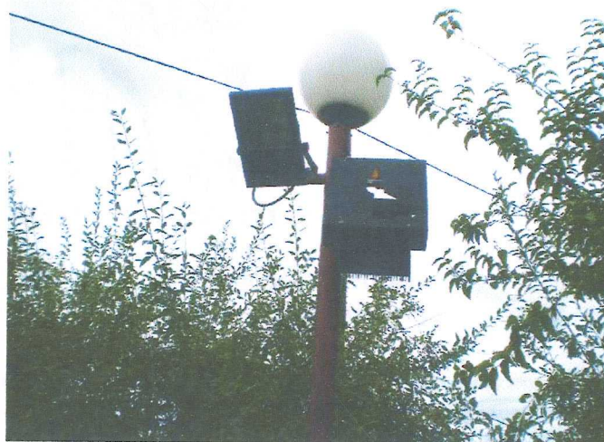
Slika 8. KUGLA KS-10 1x125 VTF + 2x400W HQI
