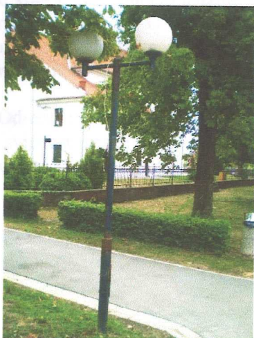
Slika 5. KUGLA KS-10 1x20W PLC
