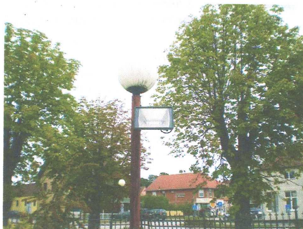
Slika 6. KUGLA KS-10 1x125 VTF + 1x400W HQI
