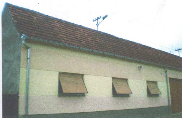
Slika 10. LVC-06 ugrađen na krovni stalak
