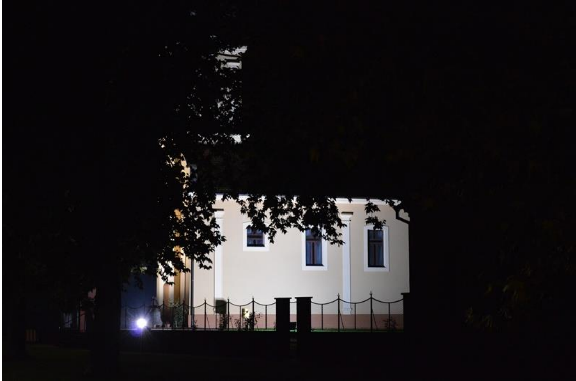
Slika 39. Nepravilno postavljena rasvjetna tijela na Crkvi
