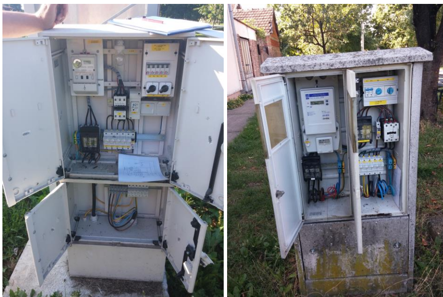
Primjer izmještenih mjernih mjesta pored TS-a
