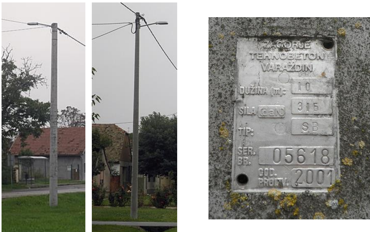
Slika 31. Armirano betonski stup
