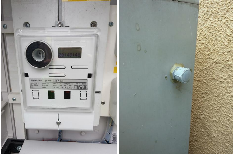
Slika 27. Astronomski uklopni sat i luxomat javne rasvjete
