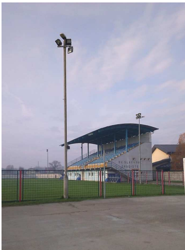
Slika 2.11. Gamalux NAV 250 W i reflektori MH 400 W Nogometno igralište
