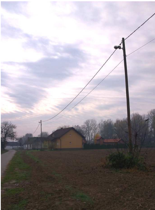
Slika 2.7. Gamalux NAV 150 W na drvenom stupu NN mreže Bosutska ulica
