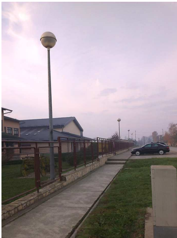
Slika 2.9. Tivoli NAV 150 W na čeličnom stupu JR Osnovna škola
